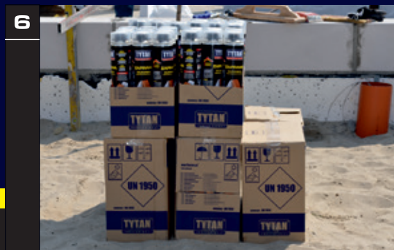
6 Достаточно только 4 коробок Клея чтобы уложить 285 м 2 стены из блоков ячеистого бетона толщиной 40 см, соединенных на шип-паз. Пистолет для нанесения Клея является инструментом для многократного использования, однако, требует тщательной очистки после использования.
