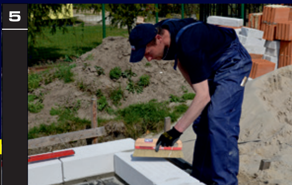
5 Клей для кладки газобетона и керамических блоков Tytan Professional создает очень тонкий шов – от 0,5 до 1,5 мм, поэтому требует очень чистой и гладкой поверхности. С поверхности блоков следует удалить пыль и ошлифовать большие неровности.
