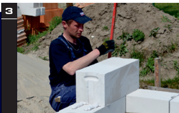
3 Точность укладки первого слоя оказывает решающее влияние на правильность выполнения всей Стены, поэтому следует тщательно проверить вертикали и горизонтالي.
