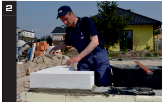
2 Первый слой стеновых элементов всегда должен быть уложен на цементной смеси для точного выравнивания поверхности, на которой будет стоять стена.
