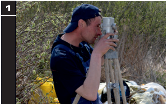
1 Перед началом кладочных работ необходимо проверить установку всех углов.
