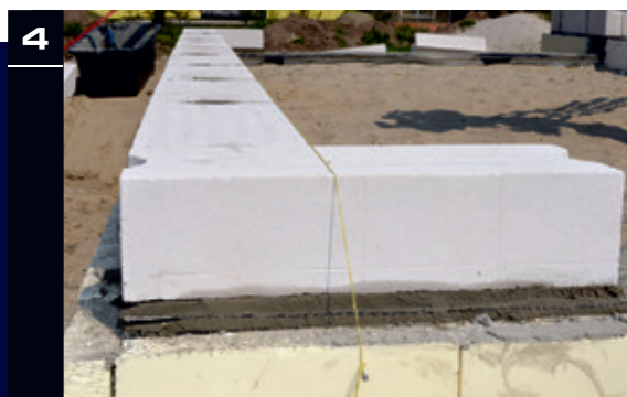
4 Веревка растянутая между углами облегчает укладку.
